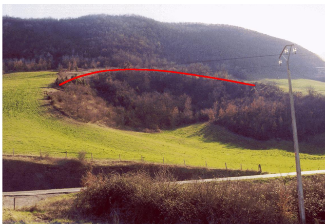
glissement de masse supposé (R.D. 992, Creissels)
