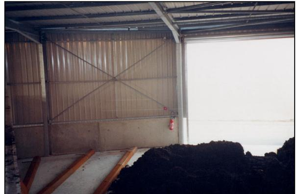
Alvéole pour fermentation , rails d'aération apparents (enceinte couverte)
