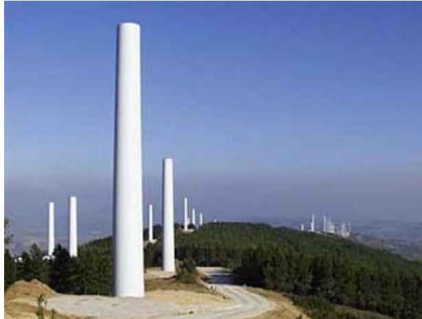
Fig. 2 : mâts tubulaires en acier (photo de gauche) et treillis (photo de droite)
