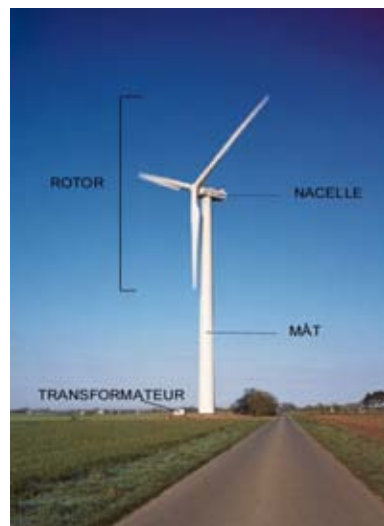
Fig. 1 : éolienne à axe horizontal.
