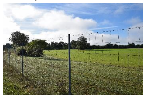
Clôture périphérique de l'aéroport Source : ARTIFEX 09/2021
