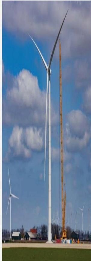
Fin Avril, les équipes d'ENERCON ont achevé avec succès la conversion du prototype de E-160 EP5 E1, installé sur le site test à Wieringermeer (Pays-Bas) depuis Octobre 2020, en E-160 EP5 E2. **Ce prototype plus puissant a ainsi été équipé d'une nouvelle génératrice et d'un nouveau moyeu.**
