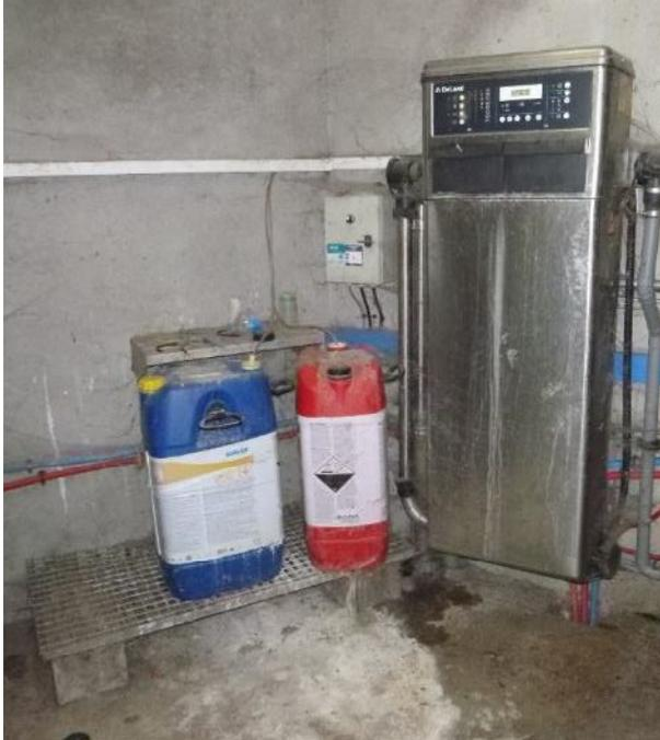
Photo 6 : bidons de produits pour le nettoyage des installations de traite
