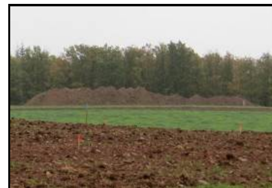
Figure 30 : Terre végétale stockée sur un chantier de centrale photovoltaïque (Source : Abies, suivi de chantier)
