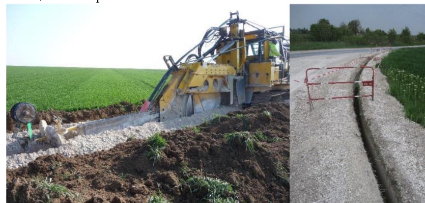
Exemple de tranchée réalisée (Source : TotalEnergies)
