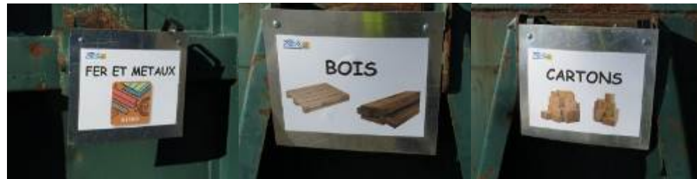
Figure 29 : Affichages sur des bennes de tri sélectif (Source : Abies, suivi de chantier de centrale photovoltaïque)
