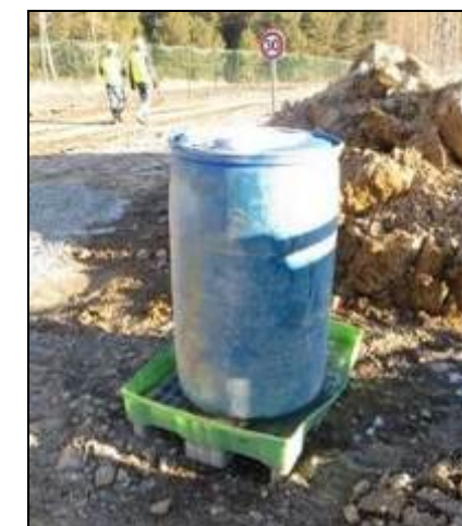
Figure 27 : Stockage d'hydrocarbures dans un bidon étanche sur bac de rétention (Source : Abies, suivi de chantier)
