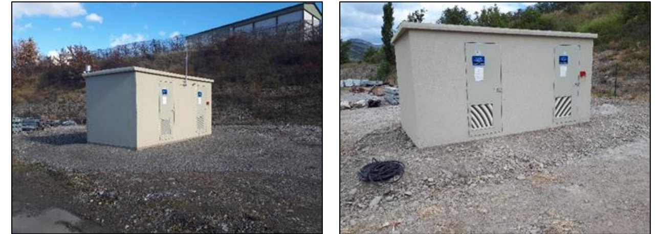
Exemples de postes de transformation en construction
