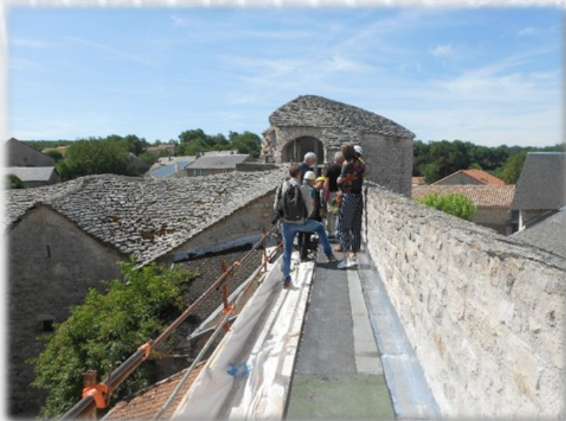
réunion de chantier sur les remparts de la Cavalerie
