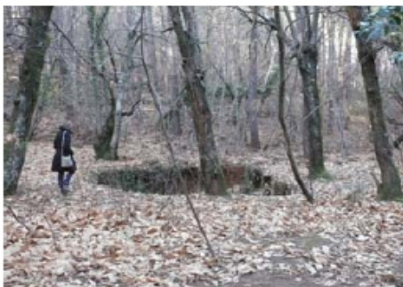
Effondrement localisé dans le Gard
