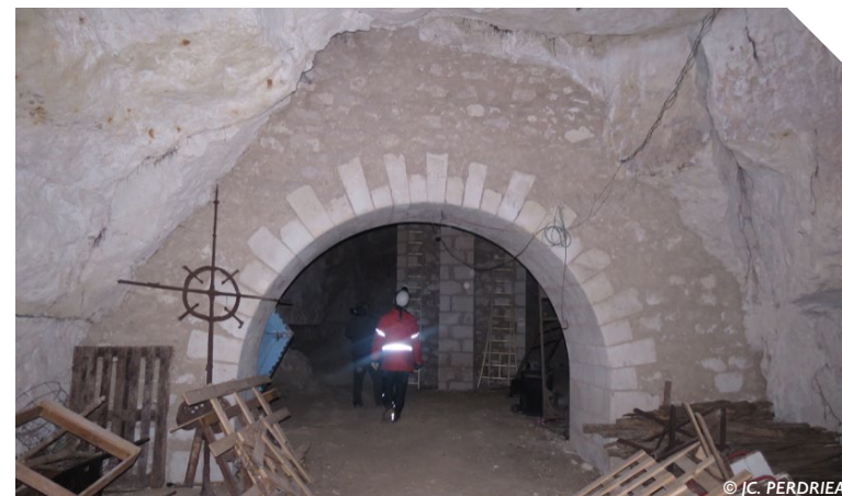
Voute maçonnée pour soutenir et consolider la cavité.
