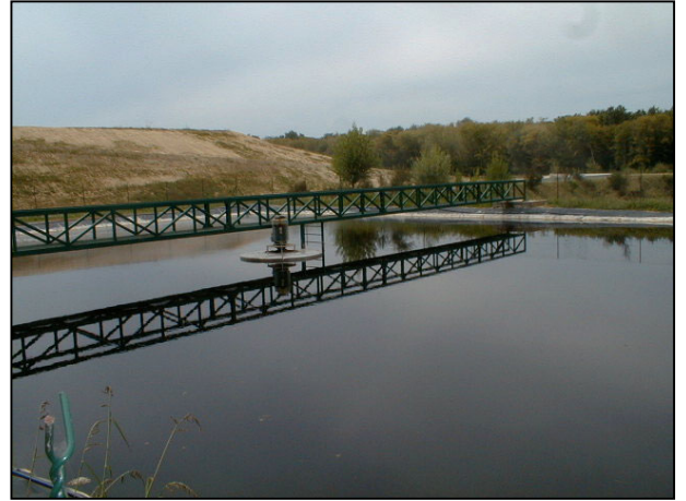
Photographie 6 : lagune pour les lixiviats
