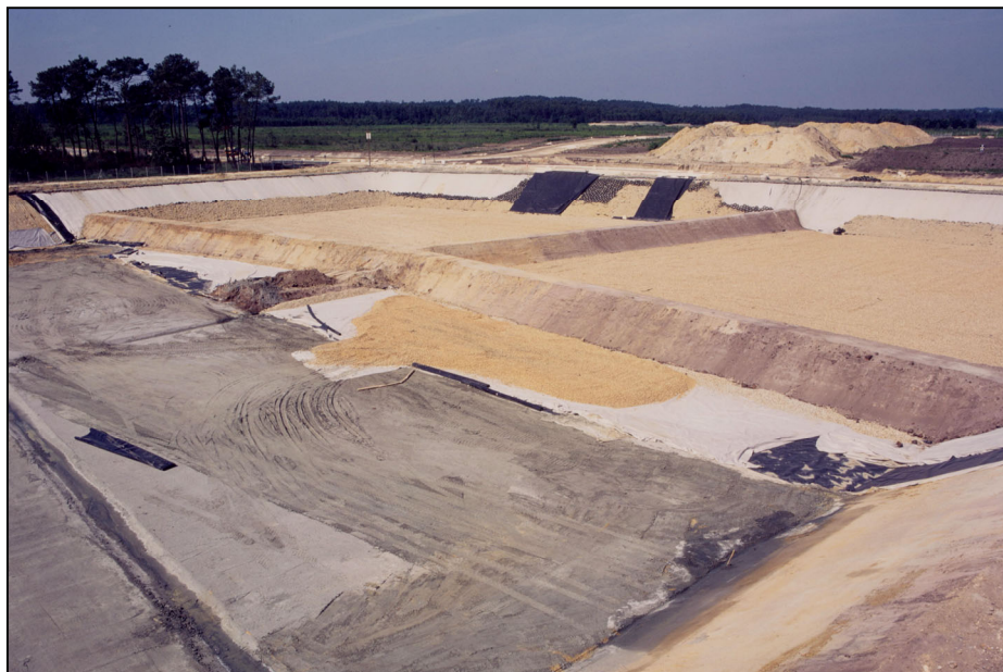
PHOTOGRAPHIE 3 : SUBDIVISION D'UN CASIER EN ALVEOLES
