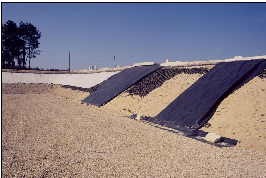
PHOTOGRAPHIE 4 : ELABORATION DE LA SECURITE ACTIVE (DE BAS EN HAUT : GEOTEXTILE SUPPORT, GEOMEMBRANE EN PEHD, GEOTEXTILE ANTIPOINÇONNANT, MASSIF DRAINANT)
