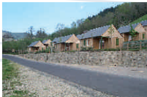
Recherche de la qualité architecturale de l'hébergement
