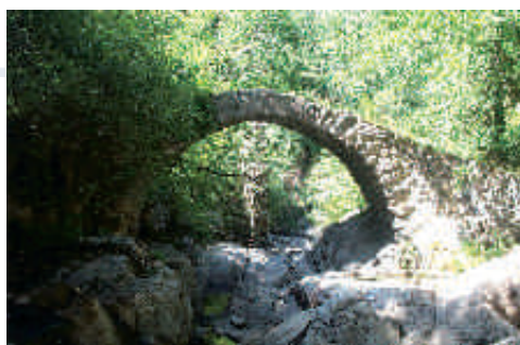
Peyrusse-le-Roc - Pont sur le torrent
