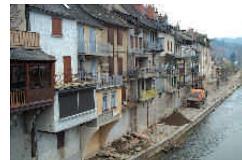
Saint Geniez : après la crue du Lot. Rechargement des rives, travaux divers
