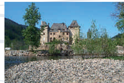
Entraygues, tenue des berges en traversée urbaine
