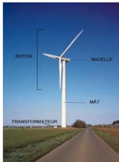
Fig. 1 : éolienne à axe horizontal.
