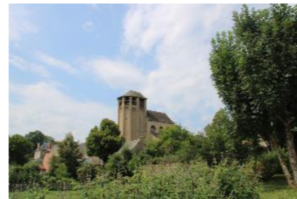
MH 4 – Eglise de Souyri Source : ARTIFEX 2021
