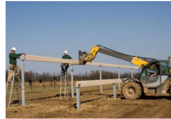
Figure 92 : Montage des structures porteuses
