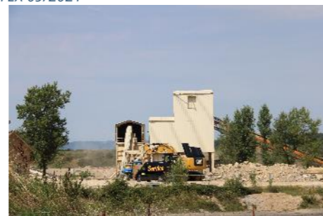
Carrière SEDEMD SAS
