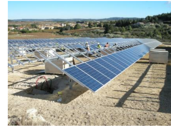
Figure 93 : Montage des modules
