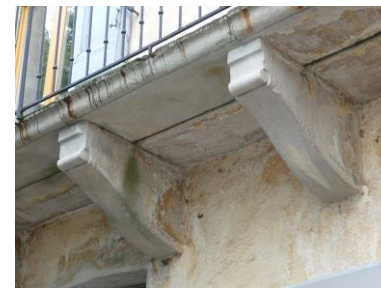
Corbeaux et sous-face de balcons
