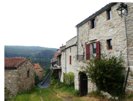
Façade d'Auriac sur la vallée du Tarn
