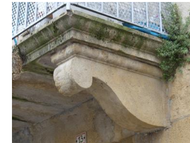
Corbeaux et sous-face de balcons
