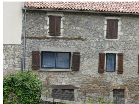
Nouveaux percements et modifications des ouvertures
