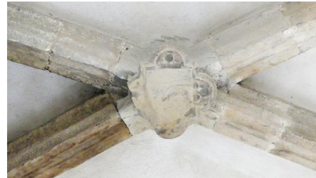
Voûte à ogive rue de la Renaissance
