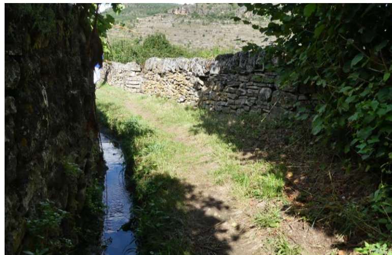
Le Lévejac aménagé : bief maçonné au Claux alimentant le moulin de Susbals et canalets d'irrigation des hortens
