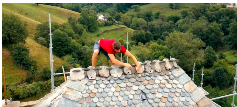
Chantier 2021 et 2022 en lauze du Cayrol à Coubisou
