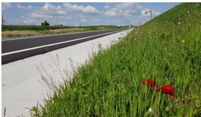
Mise en service de la déviation de Baraqueville
