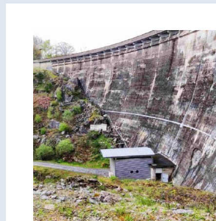
Barrage de Pareloup
