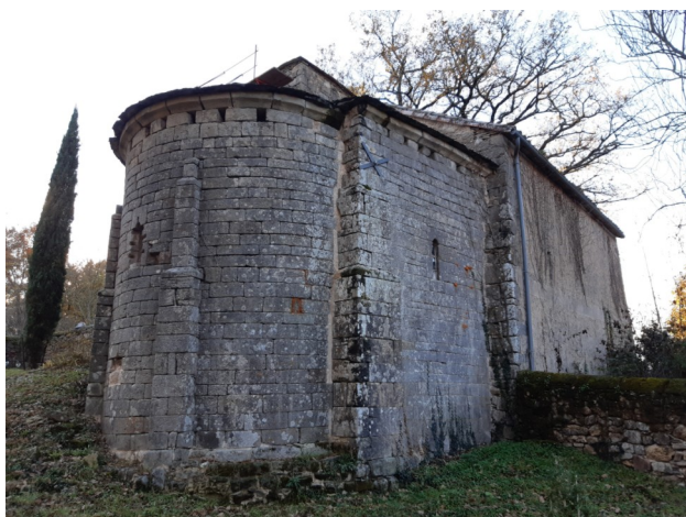
Eglise de Marnhagues - Chantier DETR - Décembre 2022
