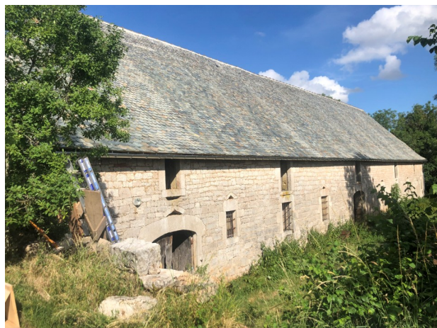
Couverture en ardoire du Cayrol neuve - Août 2022 à Dalmayrac
