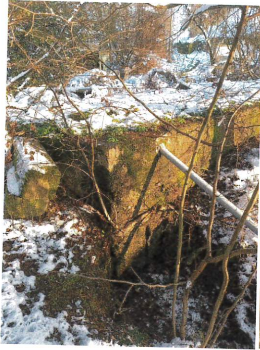
La réserve incendie en béton, on remarque sur la première photo le trop plein s'écoulant par un tuyau gris.
