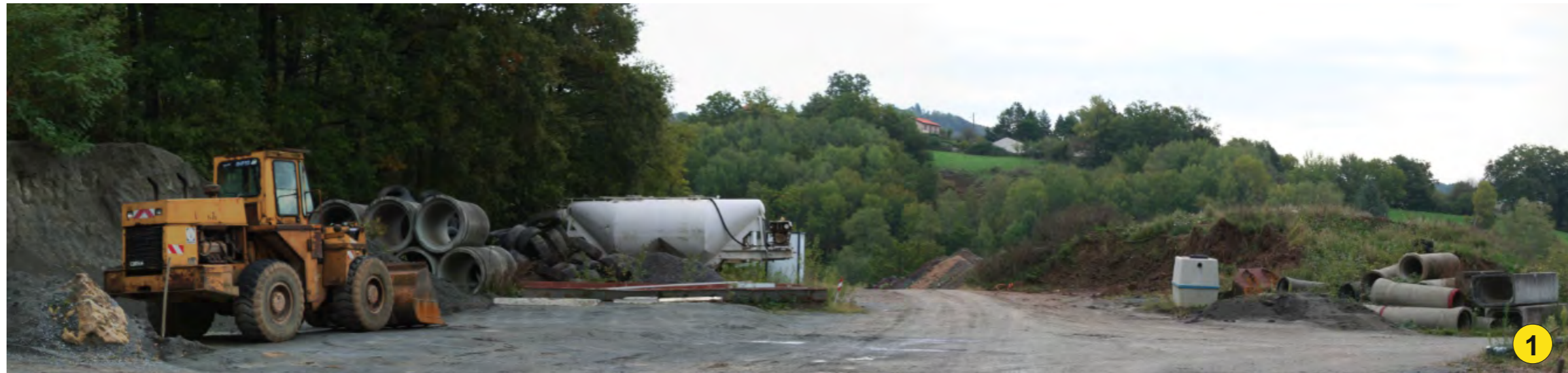
vue de la plate-forme Sud avec divers stocks et dépôt de matériel
