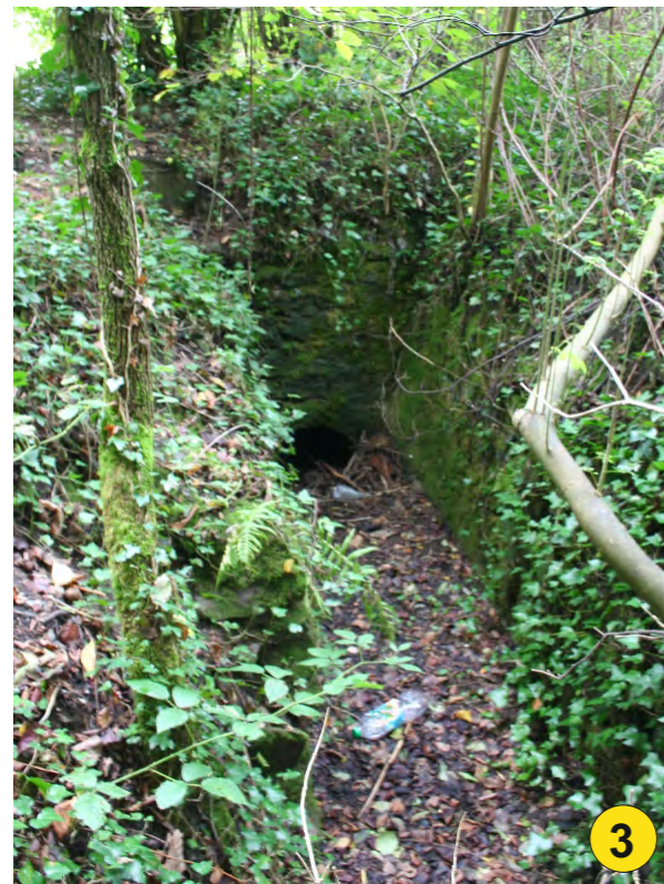
buse de départ du passage souterrain du ruisseau en aval du site
