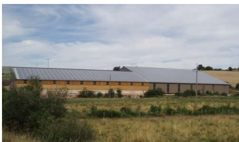
Photovoltaïque sur toiture sur le Lévézou
