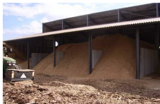
La filière bois-énergie soutenue par le FEDER
