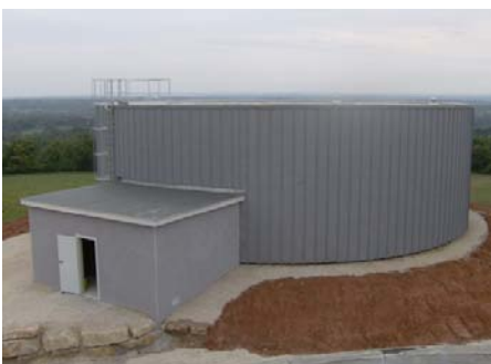
Réservoir d'eau potable du syndicat de Muret le Château
