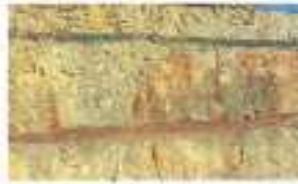
Talutage en pied de front
