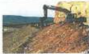
Travaux de modelage des talus
