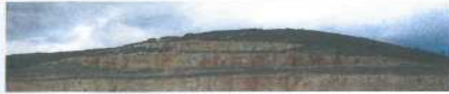
Talutage en pied de front au centre et modelage sur toute la hauteur aux extrémités, en lien avec le terrain naturel.
